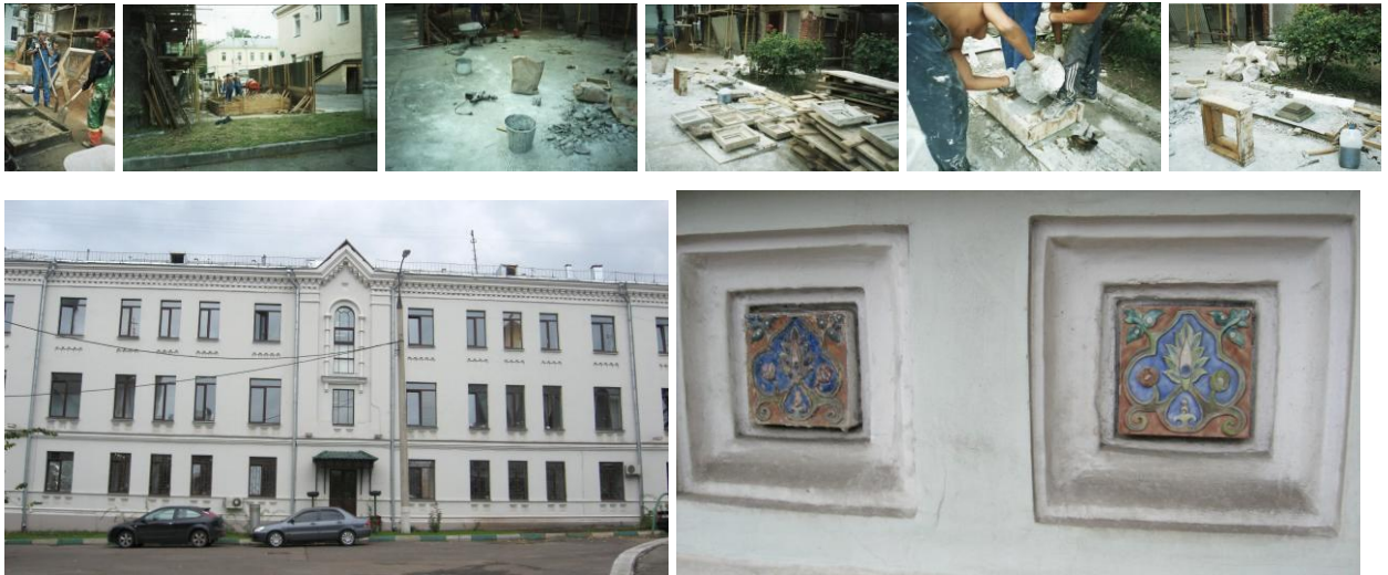
Рис. 4.2.1.1 – 4.2.1.8 Ручной способ производства БИМАФ для реставрации фасада городской больницы. Москва.
